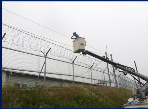
군사보호시설 군 경계력 보강시설 보수
