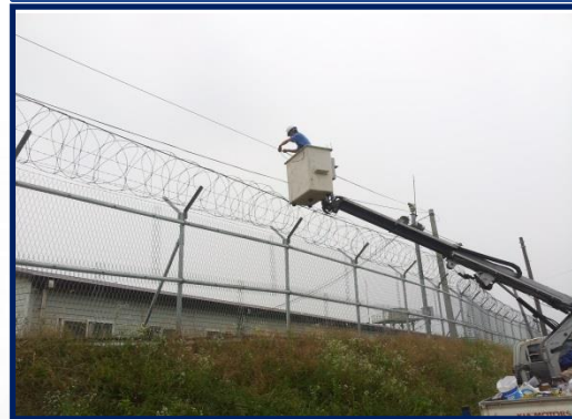
군사보호시설 군 경계력 보강시설 보수
